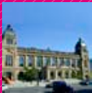
HISTORISCHE STADTHALLE Johannisberg 40 42103 Wuppertal-Elberfeld www.stadthalle.de
